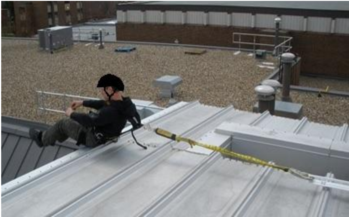
Figura 17. Em um sistema de restrição de movimentação, o comprimento do talabarte deve impedir que o tronco (região dos ombros até a pélvis) passe da borda. Fonte: Small, 2013 [47]
